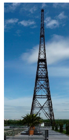
Wieża radiostacji Gliwice
